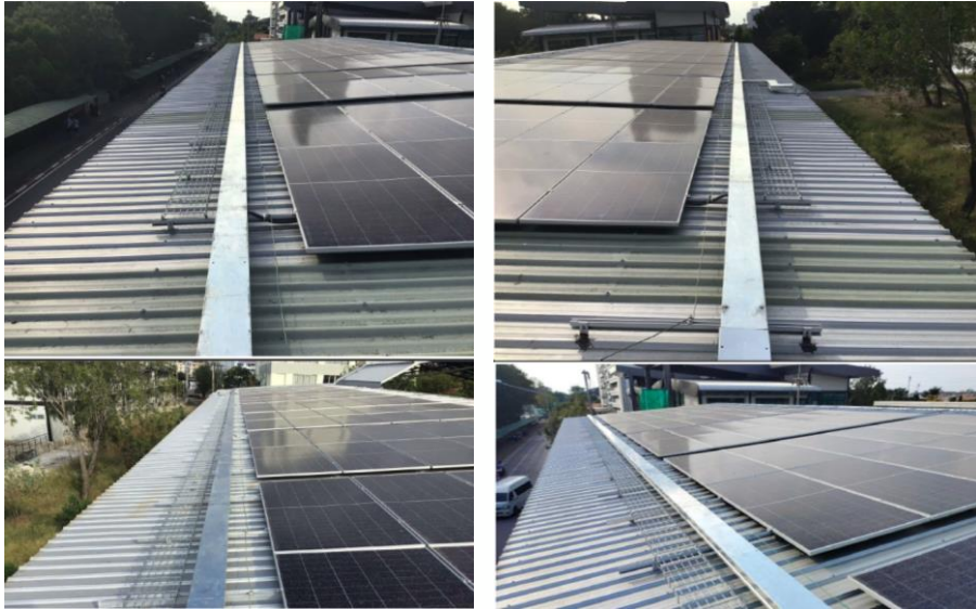
ติดตั้งรางเดินสายไฟฟ้า DC และปิดฝาครอบรางเรียบร้อยแล้ว
