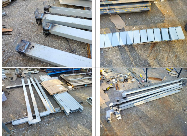
จัดทำ Support สำหรับติดตั้งตู้ MDB
