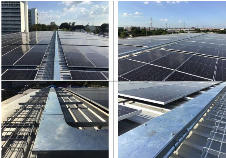
ติดตั้งรางเดินสายไฟฟ้า DC และปิดฝาครอบรางเรียบร้อยแล้ว
